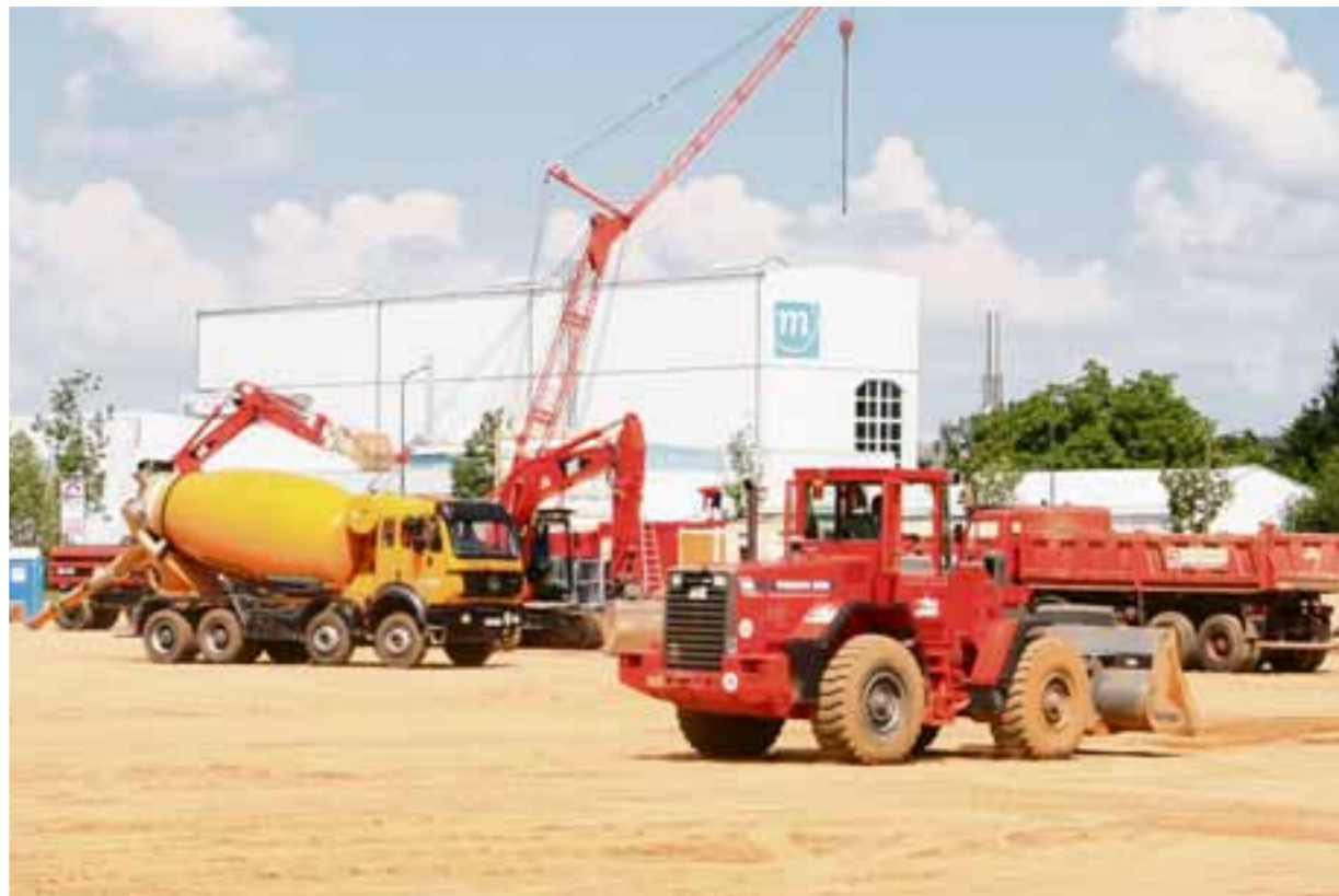
Die Baumaschinen sind bei der Arbeit: Bis Jahresende will Zenker in seine neue Produktionshalle (6000 Quadratmeter) einziehen, die an der Fritz-Mayer-Straße hochgezogen wird. Foto: Patrick Stief
